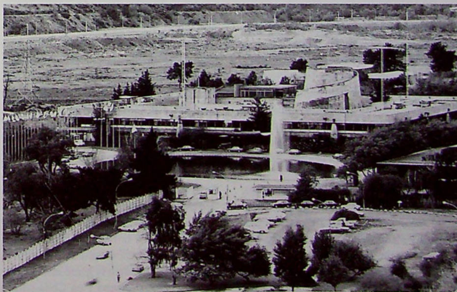
Construcción de su Sede en el sector oriente de la capital hacia 1968.
