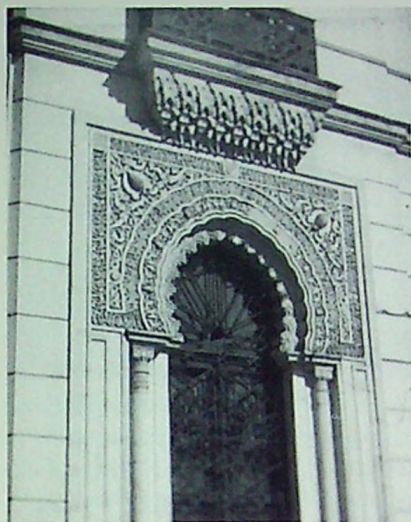
Detalle del Palacio de la Alhambra.
