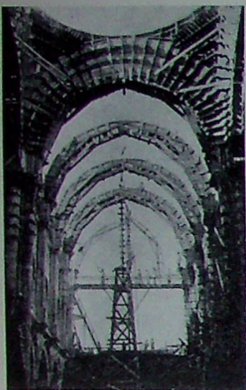
Armando los arcos de la nave central de la Iglesia Espírita (1920)
